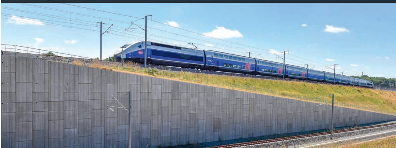
Murs en Terre Armée® sur la Ligne à Grande Vitesse (LGV) Paris - Bordeaux, France
