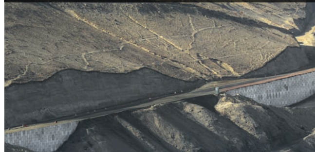
Muros de Tierra Armada® en la Línea de Alta Velocidad (LGV) París - Burdeos, Francia
