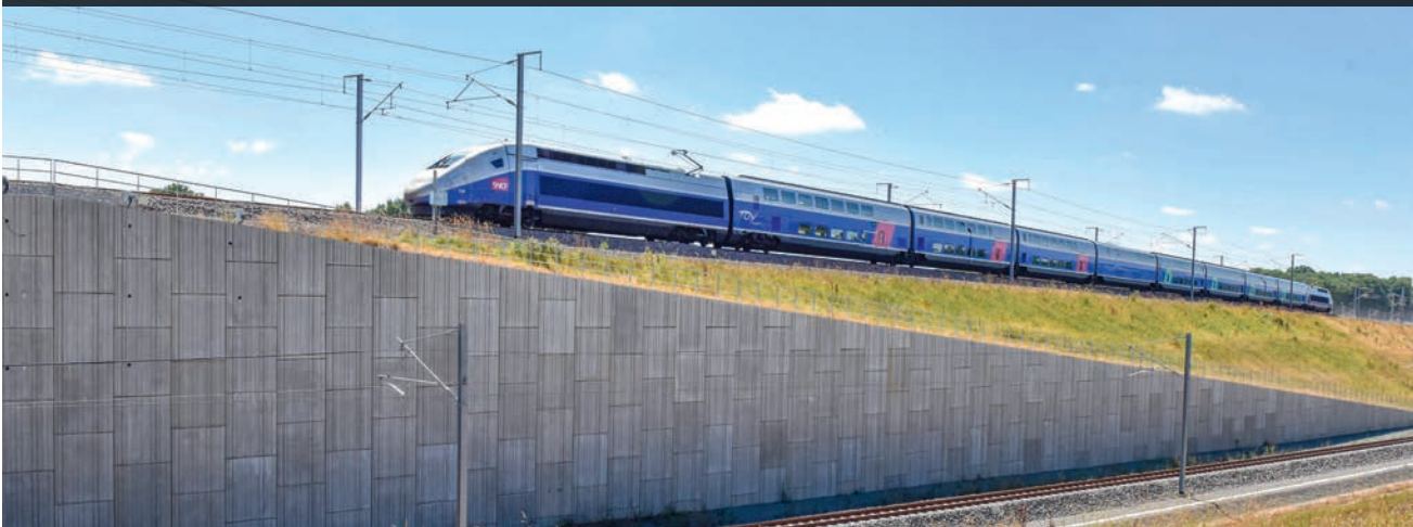
Muros de Tierra Armada® en la Línea de Alta Velocidad (LGV) París - Burdeos, Francia
