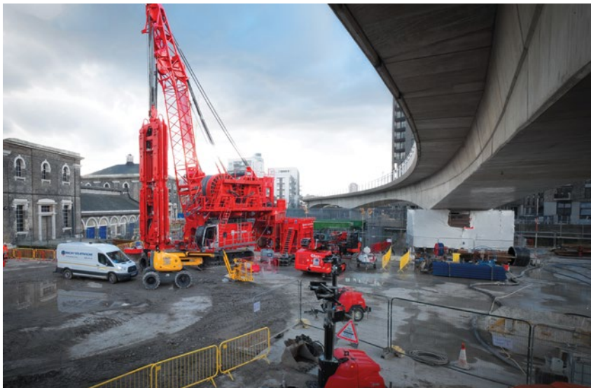
Túnel Thames Tideway, Reino Unido
