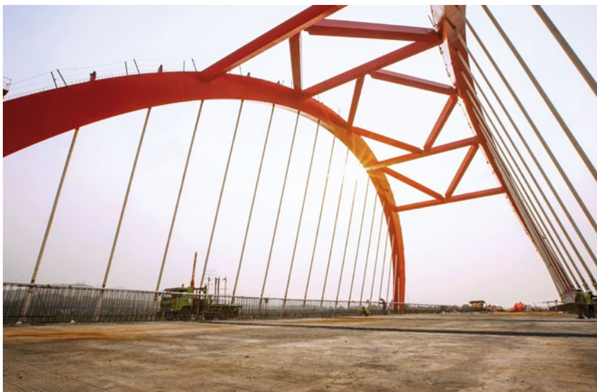
Pont de Kalikuto, Indonésie
