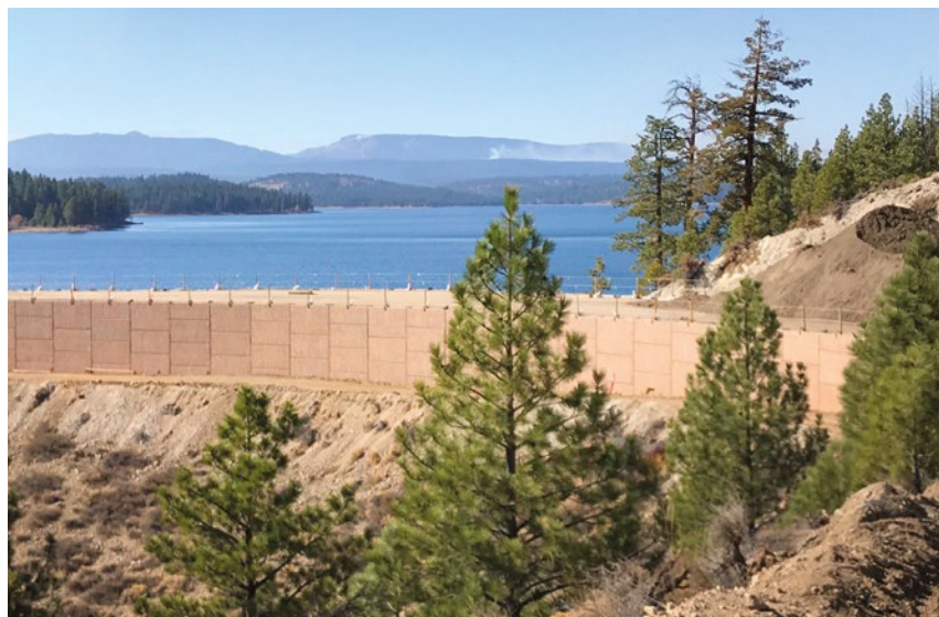
Barrage de Stampede, États-Unis
