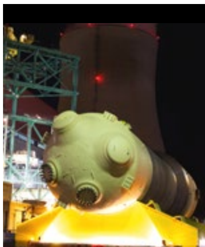
Remplacement des Générateurs de Vapeur - Cruas-Meysses
