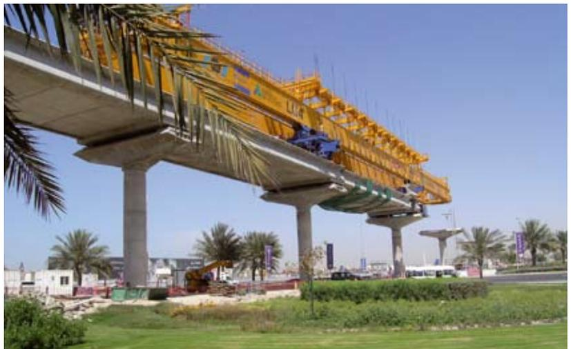
□ Appliquée à la conception et aux procédures d'utilisation des dix équipements de pose des tabliers du métro léger de Dubai, la méthode Hazid Hazop a permis de mettre en place les 16 469 voussoirs du viaduc sans incident notable.
