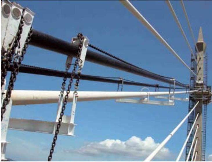
Après mise en place d'un hauban provisoire, le hauban existant est découpé et descendu d'un seul tenant. Ses ancrages dans le pylône et le tablier sont ensuite supprimés par carottage. Cinq machines spéciales ont été fabriquées par Freyssinet pour faciliter cette opération, rendue difficile par la forte concentration d'acier dans la structure.
