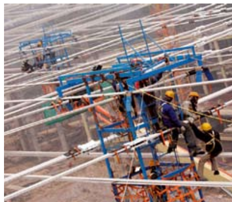
□ La techumbre de la piscina olímpica de Nueva Delhi (India) incorporará una red de cables Cohestrand®.
