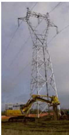
□ Obras de refuerzo con Trenchmix ligero.
