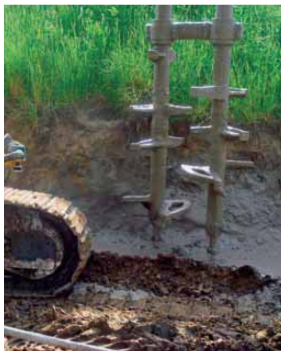
MEDIO AMBIENTE. Gracias a la técnica del soil mixing, ejecutada con doble taladro, Menard pudo declarar el suelo de una antigua planta industrial en Isère (Francia).
