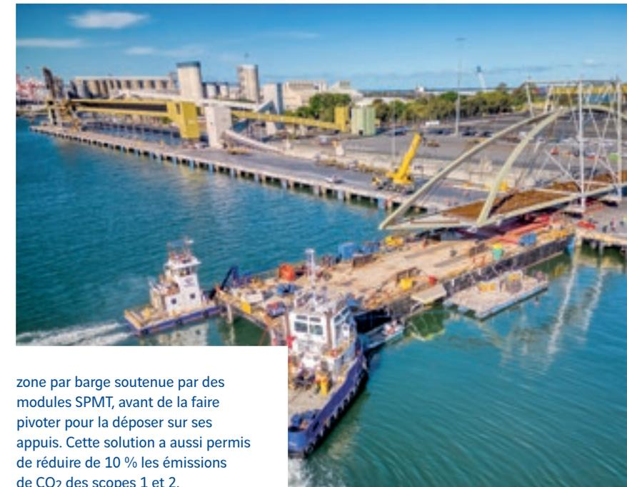
zone par barge soutenue par des modules SPMT, avant de la faire pivoter pour la déposer sur ses appuis. Cette solution a aussi permis de réduire de 10 % les émissions de CO<sub>2</sub> des scopes 1 et 2. Brady Marine & Civil a également remplacé les pieux forés en béton par des pieux en acier, pour réduire de 30 % les émissions du scope 3.
